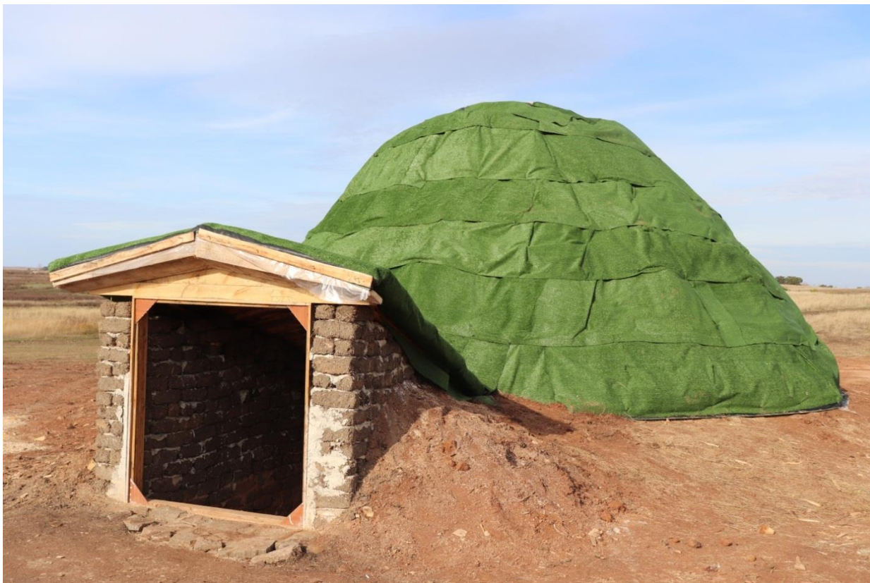
Рисунок 10 - Черепичный принцип укладки и закрепления покрытия.
